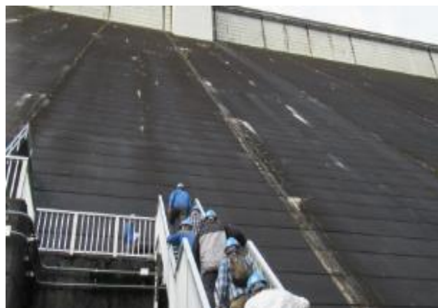
「小河内ダム」堤体内視察
