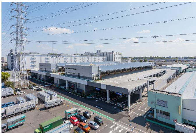
JMT板橋新1・2・5・6号棟
