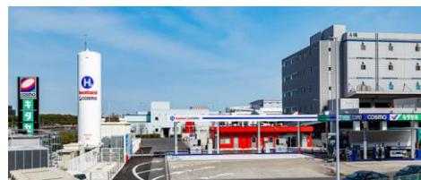
水素ステーション
