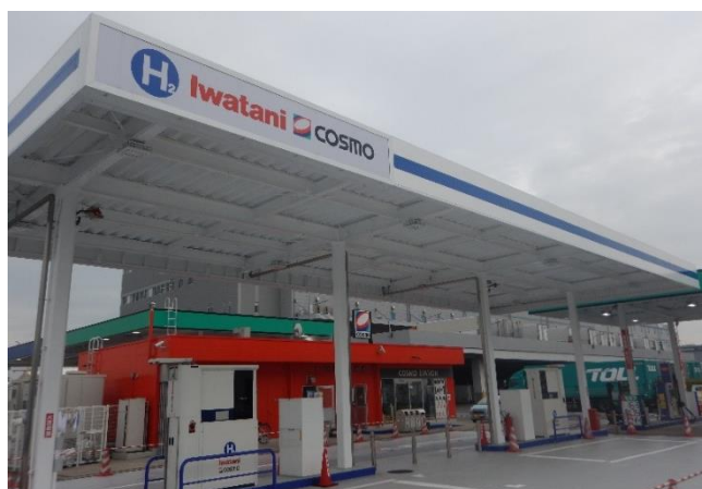
水素ステーション
