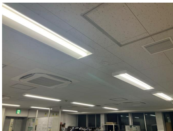
空調・照明更新後
