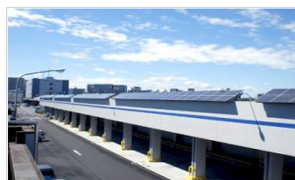
太陽光発電設備
