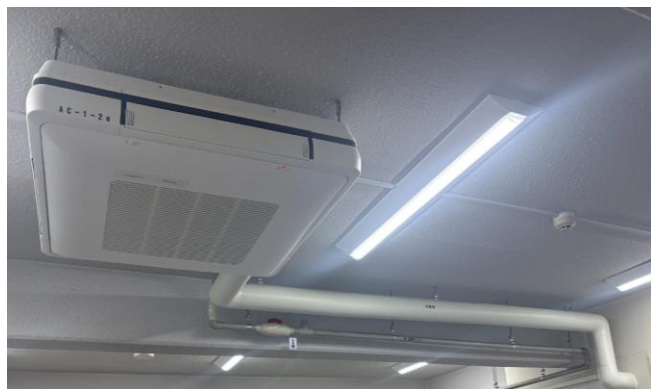
空調・照明更新後（足立TT）
