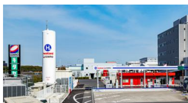
水素ステーション
