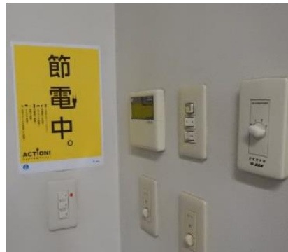
京浜トラックターミナル管理棟
