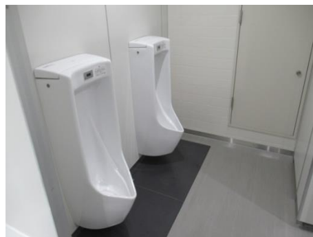
葛西トラックターミナル10号棟
