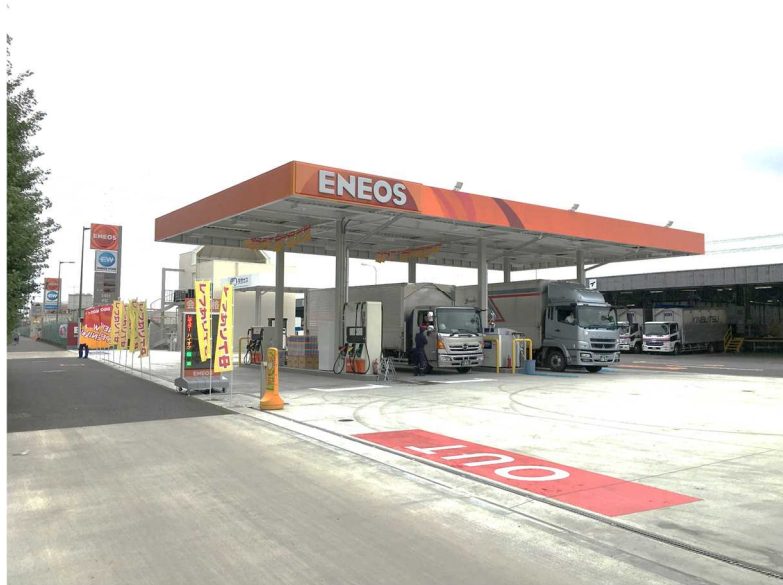
完成した新給油所の全景
