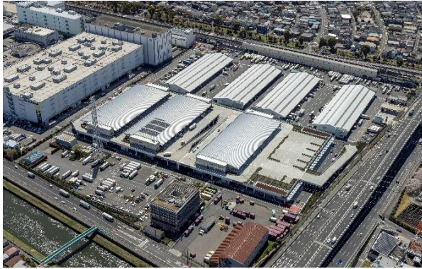
板橋トラックターミナル空撮
